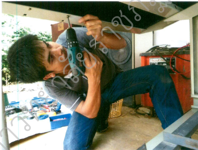
รูปที่ ข 2.1.4 ติดตั้งแผงโซล่าเซลล์
