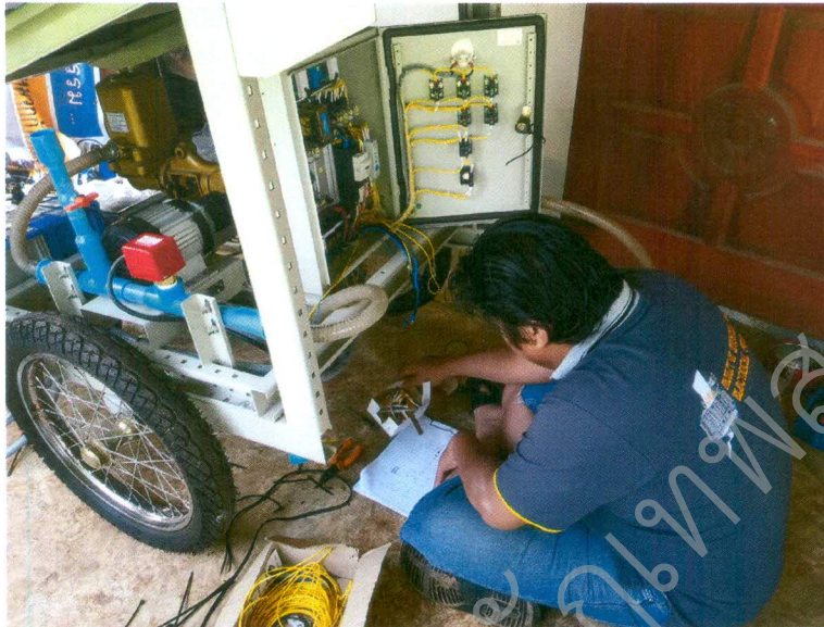
รูปที่ ข.2.4.1 ติดตั้งตู้คอนโทรลหลักเข้าเครื่อง
