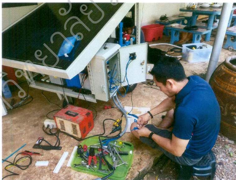
รูปที่ ข.2.4.2 ติดตั้งตู้คอนโทรลชุดชาร์จเจอร์
