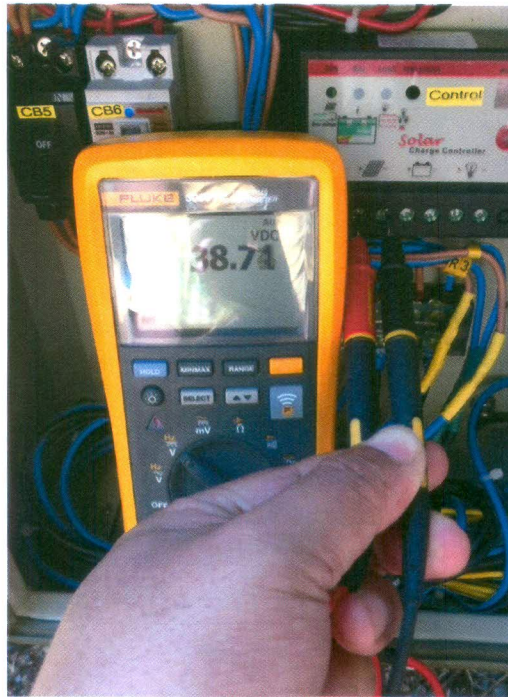
รูปที่ 4.9 แสดงการวัดแรงดันโซลาร์เซลล์ด้านอินพุท ของชาร์จเจอร์คอลโทรลเลอร์
