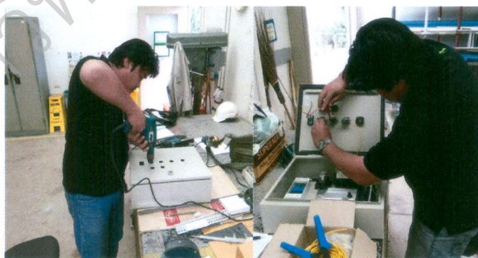
รูปที่ 3.19 แสดงการติดตั้งและประกอบหน้าตู้ ระบบควบคุม
