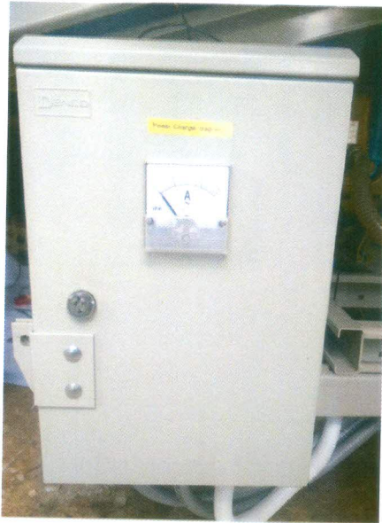
รูปที่ ก.6 ตู้คอนโทรลเหล็กขนาด 300x450x200 mm.
