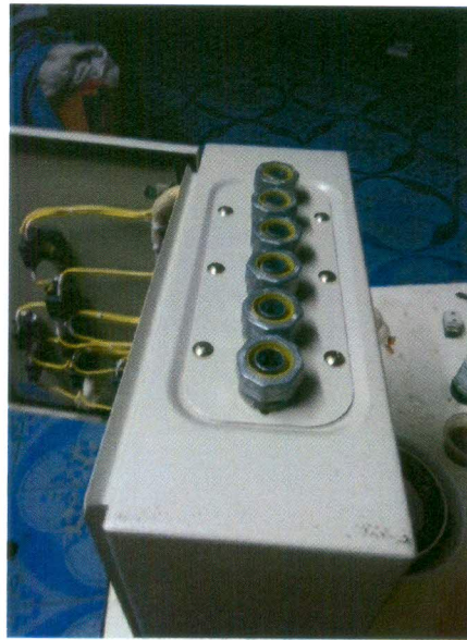
รูปที่ ข.2.2.7 จัดวางอุปกรณ์ไฟฟ้าชุดคอนโทรลหลัก(ต่อร้อยสายไฟฟ้า)
