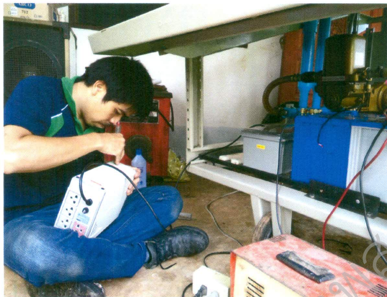
รูปที่ ข.2.4.3 ติดตั้งแอมเตอร์และตัวสำรองไฟ
