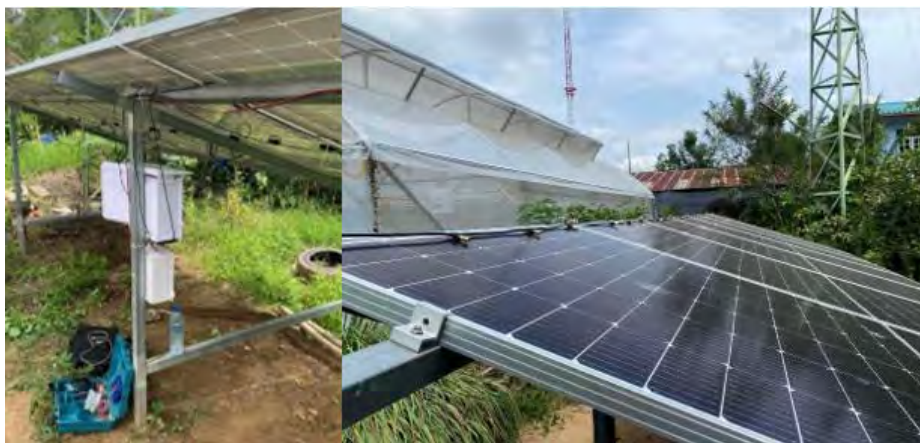
ภาพที่ 7.1 การติดตั้งอุปกรณ์ลดอุณหภูมิของแผงโซลาร์เซลล์ ที่มา: อธิภัทร แสงไชย และศักดิ์ชัย อินจู (2568)
